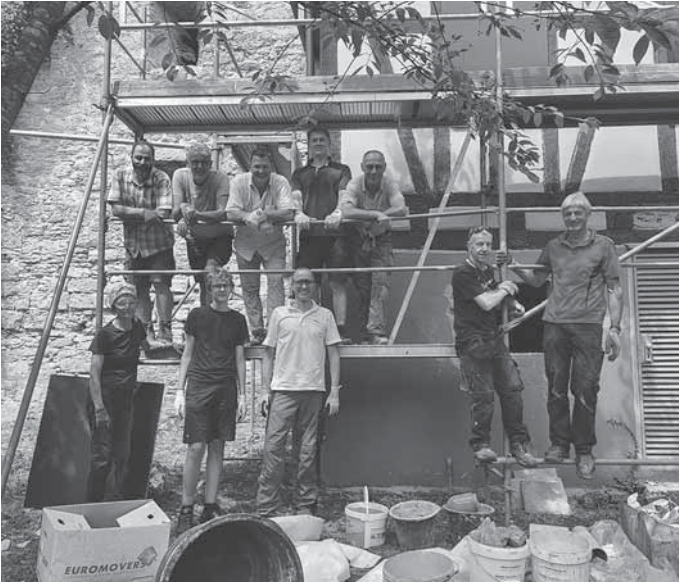
Freiwillig Engagierte sanieren das Torwächterhaus Langenburg.
