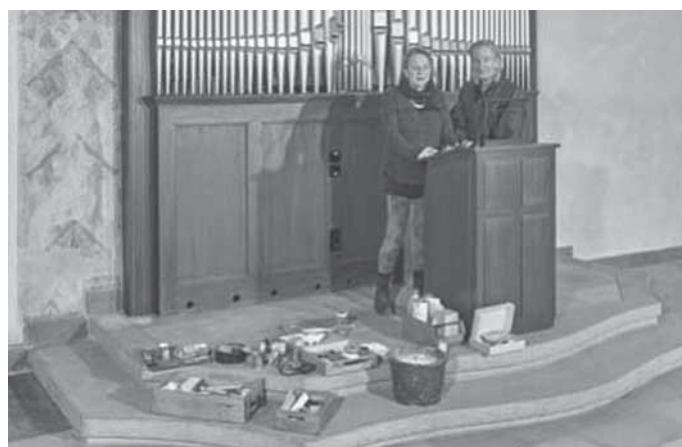
Restauratorensgemeinschaft Brückner & Welbers bei Restaurierungsarbeiten in der Backnanger Aussegnungshalle auf dem Stadtfriedhof Nov. 2025 Foto: BJ. Lattner
