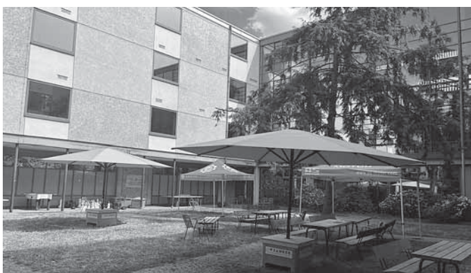
Die neu installierten Großschirme im Innenhof des Max-Born-Gymnasiums.
