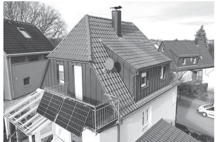
Balkon-PV-Anlage der BES: Beratung und Sammelbestellung für Module und Befestigungsmaterial
