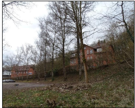
Abb. 5: Böschungsbereich entlang der Eugen-Adolff-Straße
