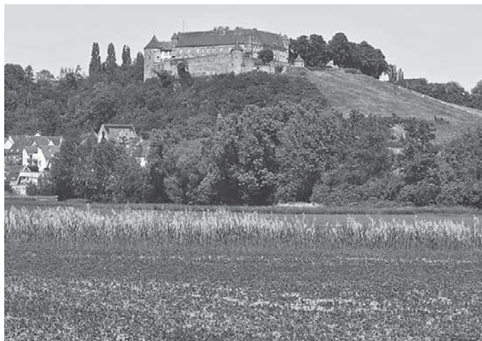
Blick auf Burg Stettenfels
